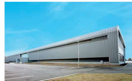
さくらインターネット(株)石狩データセンター
