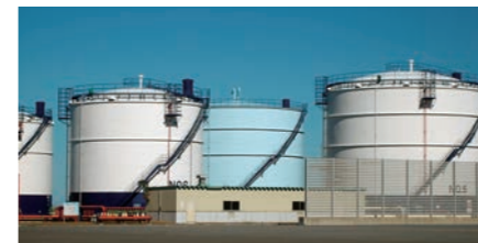
オイルターミナル
