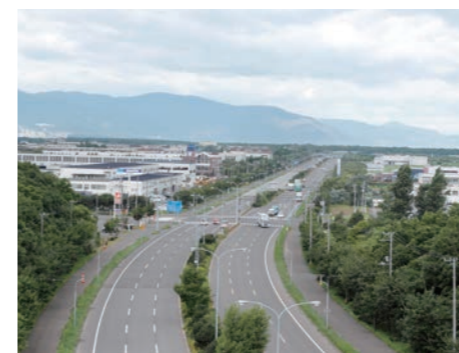
小樽石狩線(道道225号)
