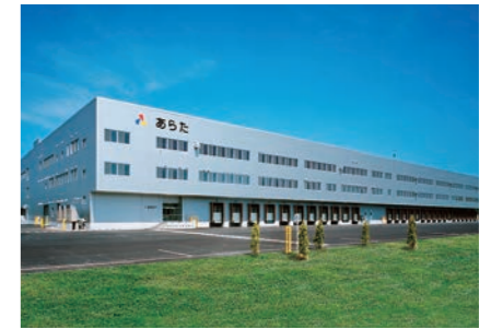
株式会社あらた 石狩センター
