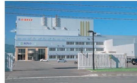
ホクレンバールライス工場
