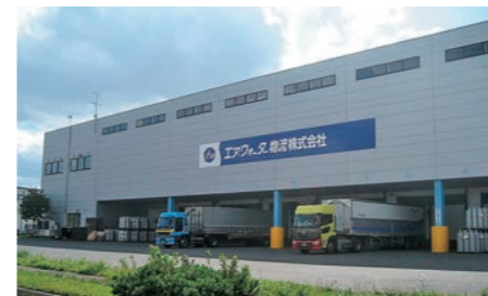
エア・ウォーター物流(株)石狩流通センター
