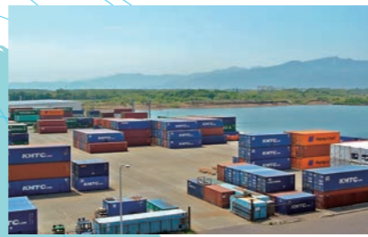
コンテナヤード
