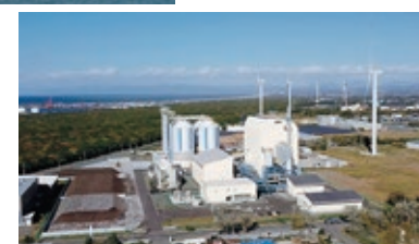
石狩新港バイオマス発電所
