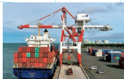
ガントリークレーン
