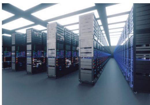
▲DC内のサーバールーム(イメージ)
