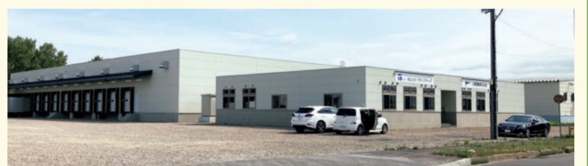
▲石狩物流センター
