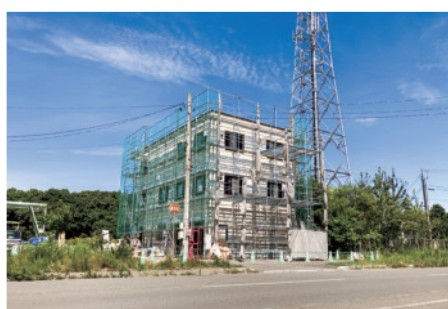
▲地域内で進められている主な建設現場
