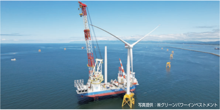
▲建設工事中の風力発電施設
