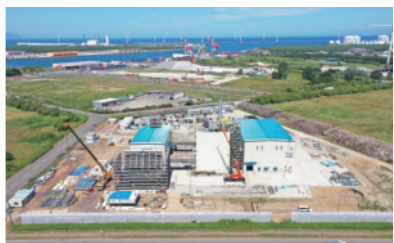
▲石狩地域バイオマス発電所（建設中）
