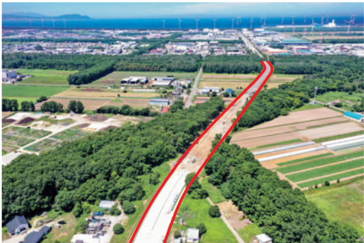
▲石狩市街地からみた工事現場 (2025.07 撮影)
