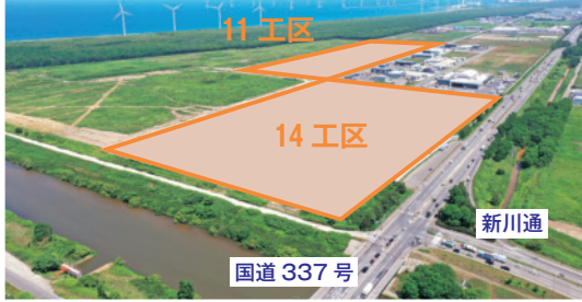
▲造成中の銭函第11工区、14工区
