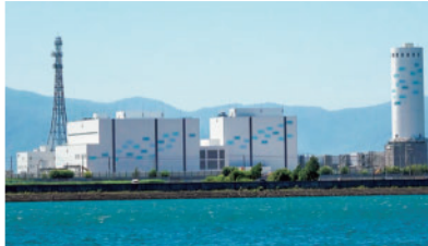
▲北海道電力石狩湾新港発電所（写真提供：北海道電力様）
